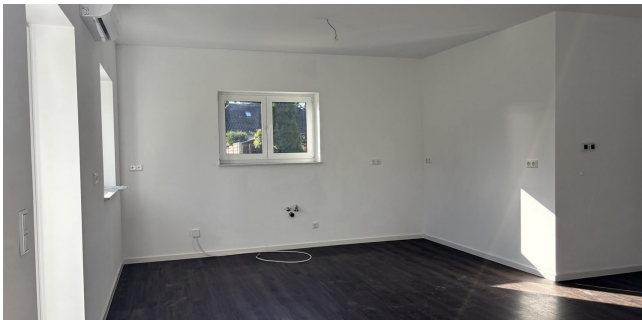
Küchenwand mit vorhandenen Wasseranschlüssen
