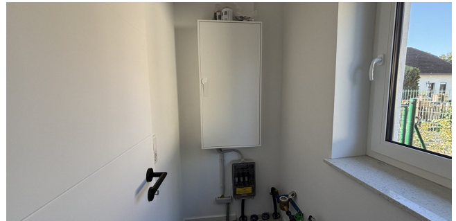
Hauswirtschafts- und Technikraum
