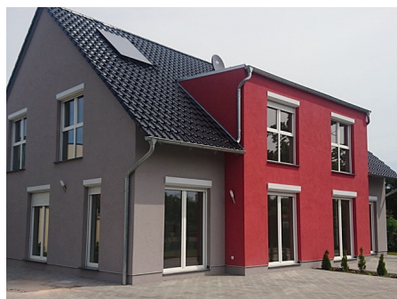
Ansicht von der Zufahrt: links die eine, rechts die andere Haushälfte
