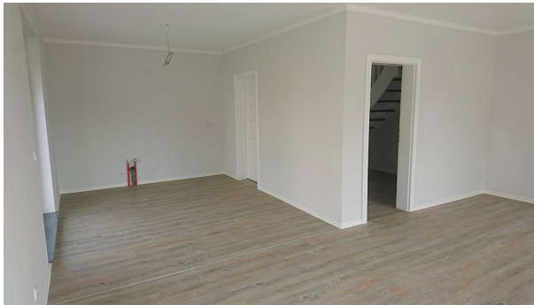
Küchenwand mit Durchgang zur Diele
